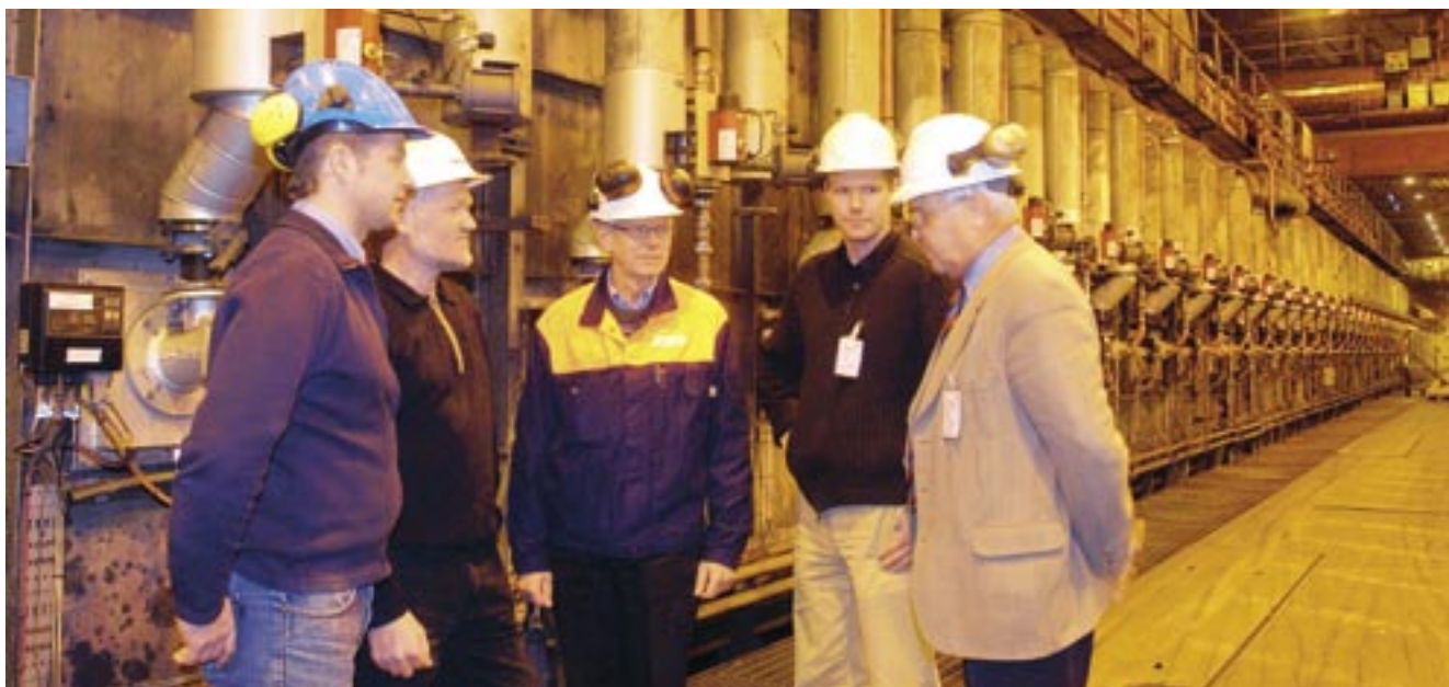
Bilden visar den aktuella anläggningen med, från vänster: vår projektledare Jari Koski, vår brännartekniska expert Poul Erik Kjær, projektledaren från SSAB, Christer Enström, vår konstruktör Johan Häggblad samt vår tekniske chef Anders Jerregård.
